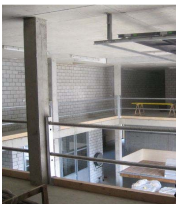
Die Innenansicht vom Werkhof.
