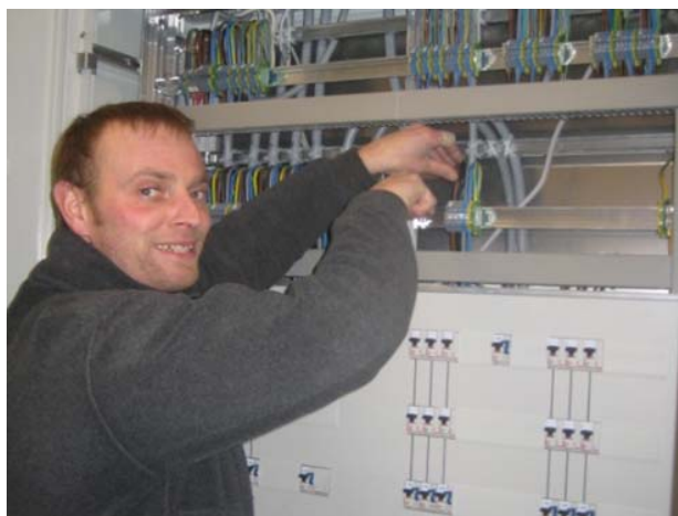
Teamleiter Adrian Hool beim Anschliessen der neuen Verteilung für die Küche.
