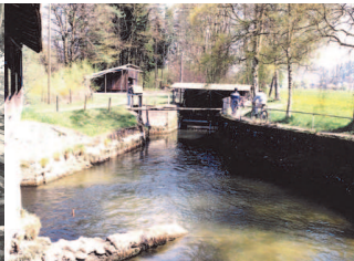
Kanaleinlauf bei der Schwelli
