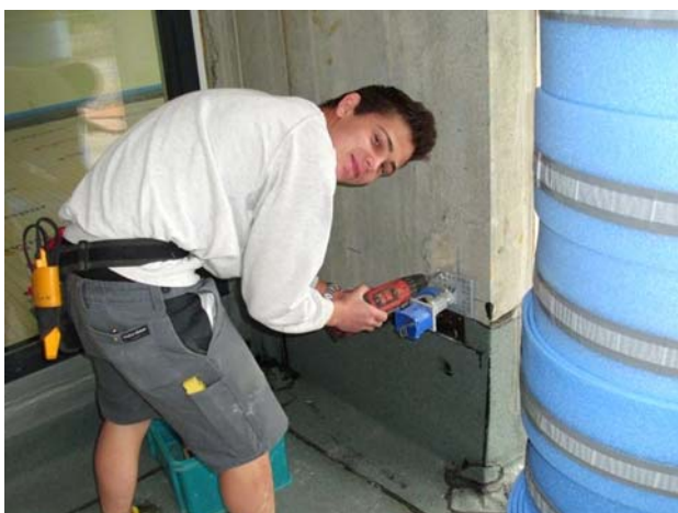
Michael Emmenegger bei Rohbauarbeiten an der Fassade.
