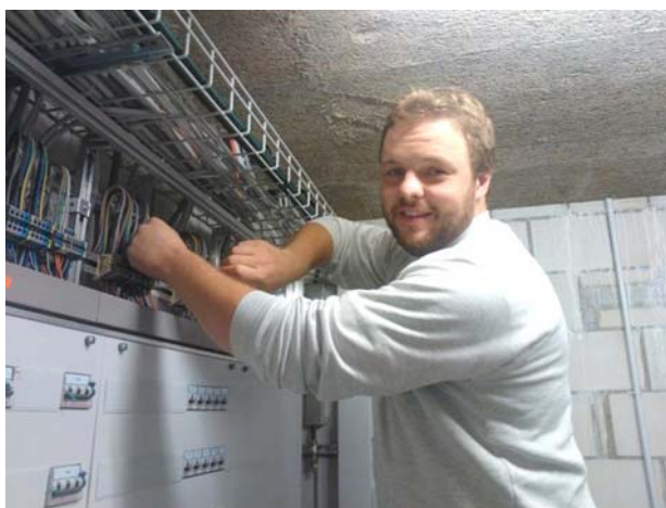
Teamleiter Thomas Hoesli beim Anschliessen der Hauptverteilung.
