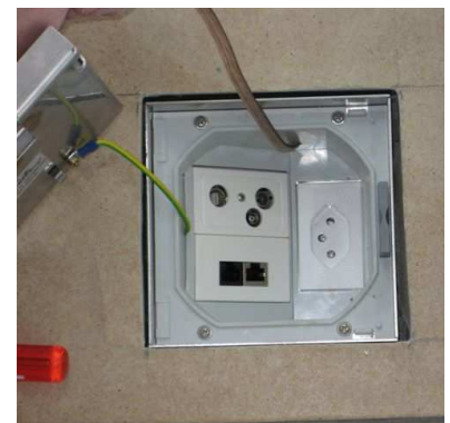
Bodendose von Feller mit den gleichen Komponenten
