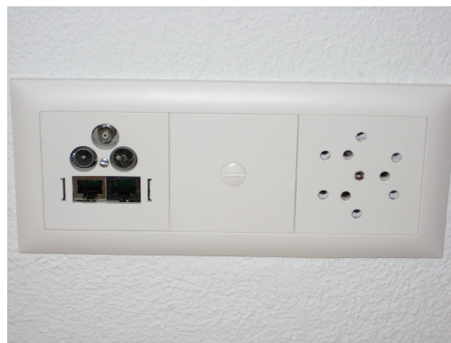
Kombination mit TV-, Netzwerk-, Telefon- und 230V Steckdose
