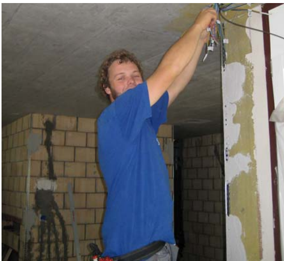
Teamleiter Thomas Hoesli bei Drahteinzügen nach Rohbauvollendung.
