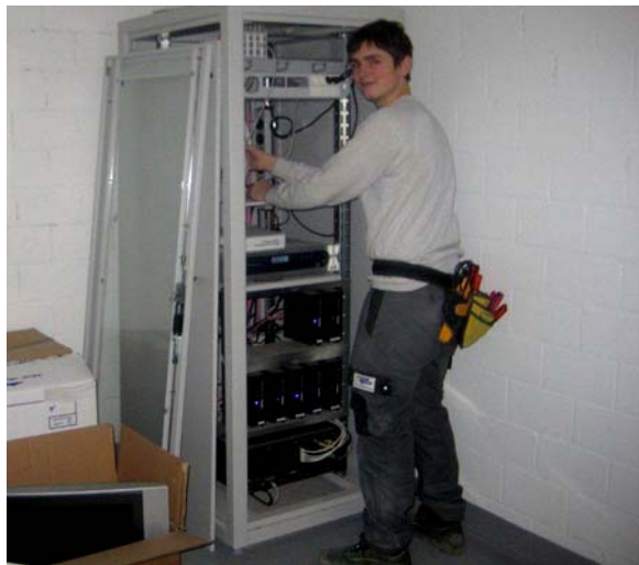
Basil Bachmann beim Zusammenbau des Multimedia-Racks für die Wohnung im Erdgeschoss .
