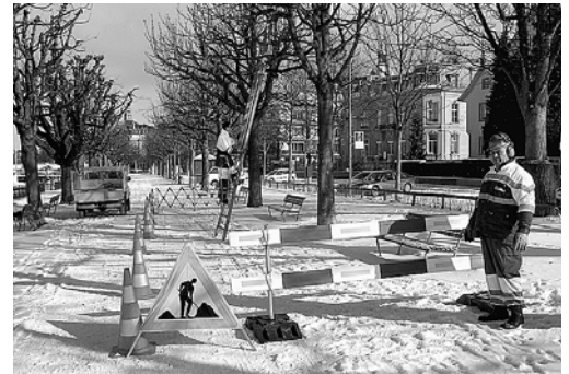
Bild 1: Der Gefahrenbereich ist signalisiert und für Drittpersonen abgesperrt.
