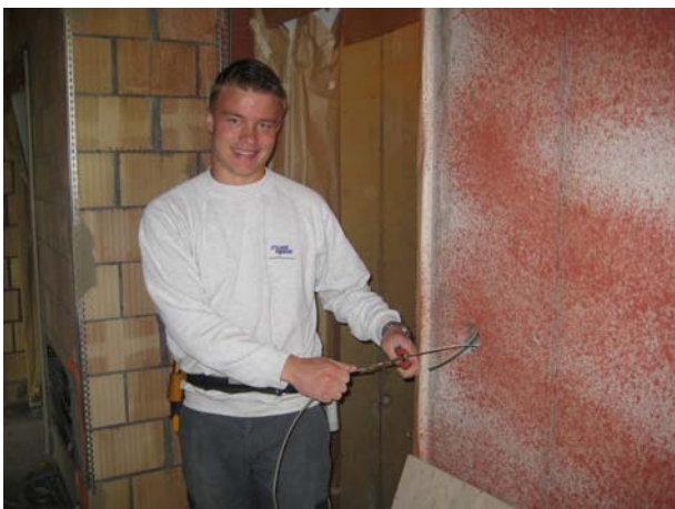
Elektroinstallateur Adrian Ineichen beim Drahteinzug.
