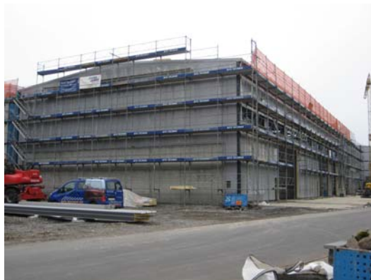
Das Wohn- und Gewerbegebäude während den Rohbauarbeiten.
