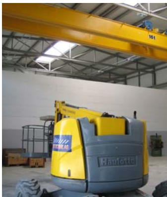
Die Installationen wurden mit Hebebühnen erstellt.
