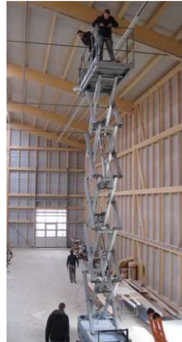
Basil Hurni und Maurus Bachmann bei der Montage der Lichtbänder im Landi-Laden Wolhusen.
